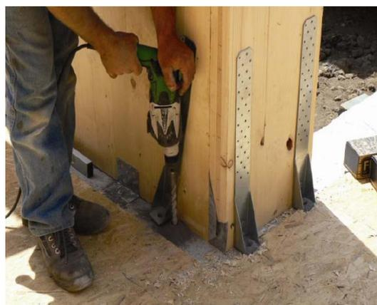
*Il sistema costruttivo e la modalità di ancoraggio dei pannelli X-lam*
