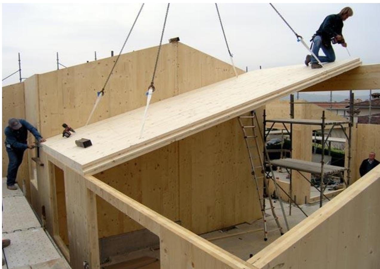
*Realizzazione di un tetto a falda con pannelli X-Lam*
