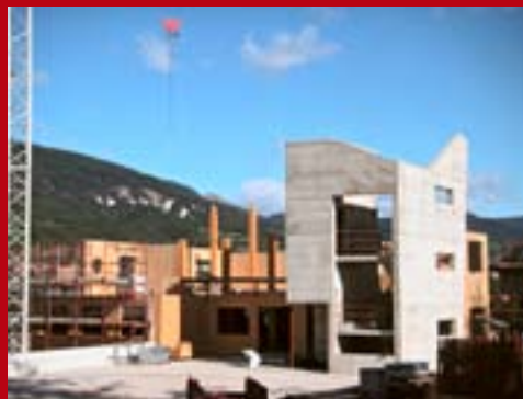
DEMOLIZIONE E RICOSTRUZIONE. Alcune fasi dell'intervento di riqualificazione, che ha visto la parziale demolizione dell'edificio, la ricostruzione dei livelli superiori e l'aggiunta di un vano scale e ascensore.
