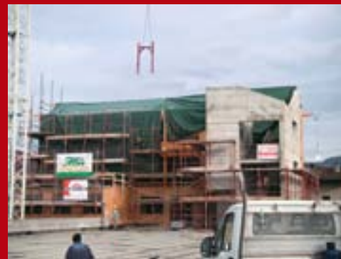
DEMOLIZIONE E RICOSTRUZIONE. Alcune fasi dell'intervento di riqualificazione, che ha visto la parziale demolizione dell'edificio, la ricostruzione dei livelli superiori e l'aggiunta di un vano scale e ascensore.
